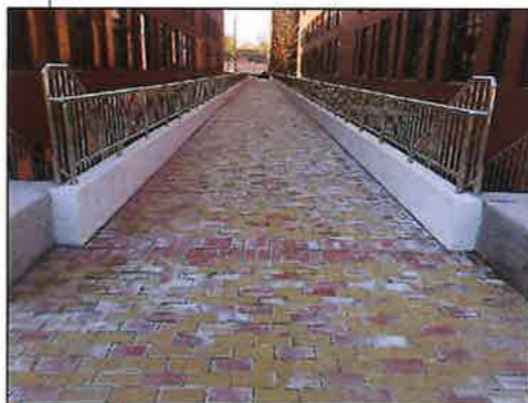
透水砖铺装3282m 2
